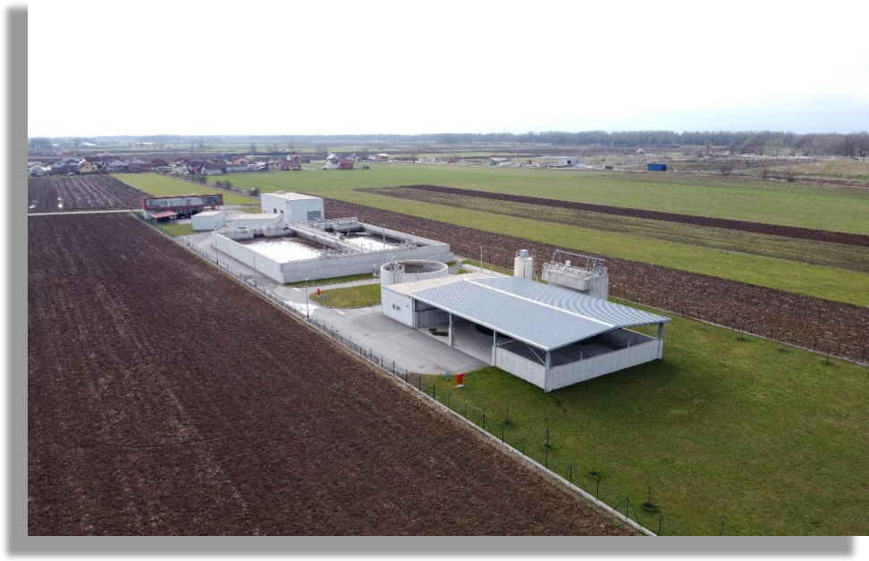
Slika 20. Pročistač otpadnih voda u Županji (1)
