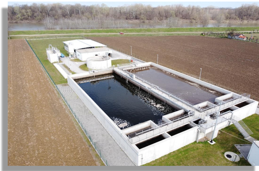
Slika 21. Pročištač otpadnih voda u Županji (2)
