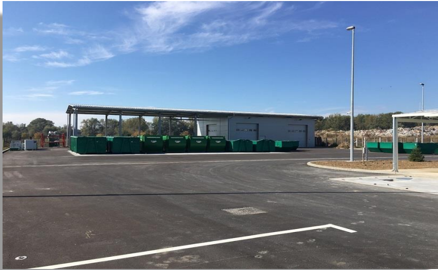
Slika 31. Čistoća d.o.o. Županja - reciklažno dvorište
